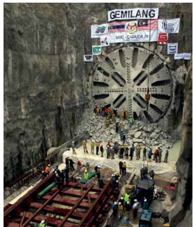
1 Durchschlag der SMART-TBM im Jahr 2006 Breakthrough of SMART TBM in 2006
